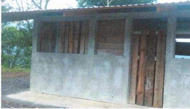
Foto1: Fotografía de las ventanas que requieren sustitucion de ventana de madera por ventanas de metal.
